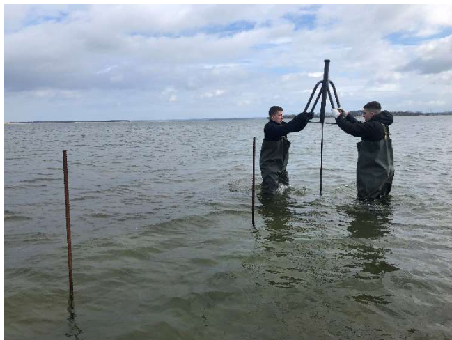
Aufbau des Knotengeflechtzaunes an der Ostseite...
